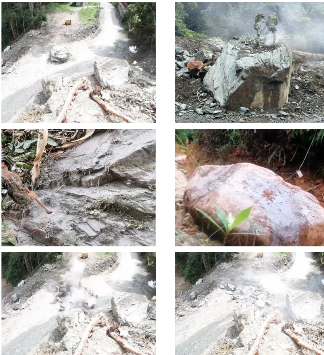
Imagen 6. Muestra el proceso seguido en la fragmentación de bloques de rocas, en corredores viales. (a) Presencia de 3 bloques de roca que obstruyen vía que comunica la ciudad de Ibagué con los municipios de Combeima y Villa Restrepo (Tolima). (b) Proceso de perforación de barreno en bloques de roca. (c) Proceso de carga y tacado de explosivo en bloque. (d) Línea de tiro para ejecución de la detonación de fragmentación. (e) Momento de la detonación para fragmentar el 1er bloque de roca. (f) Resultado de la detonación para la fragmentación del 1er bloque de roca
