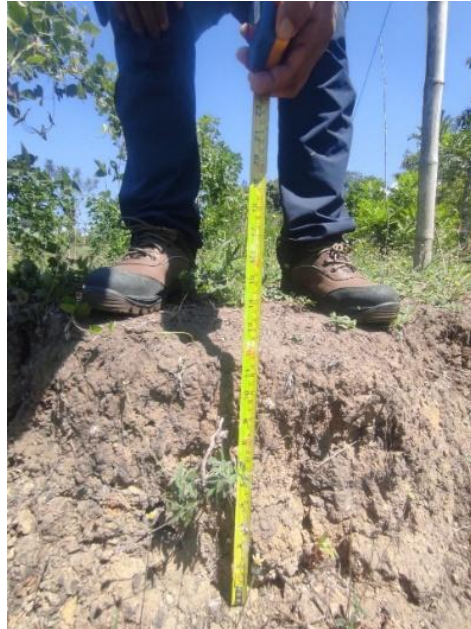
Figura 9. Escarpe del deslizamiento y medición de altura en el sitio de estudio
