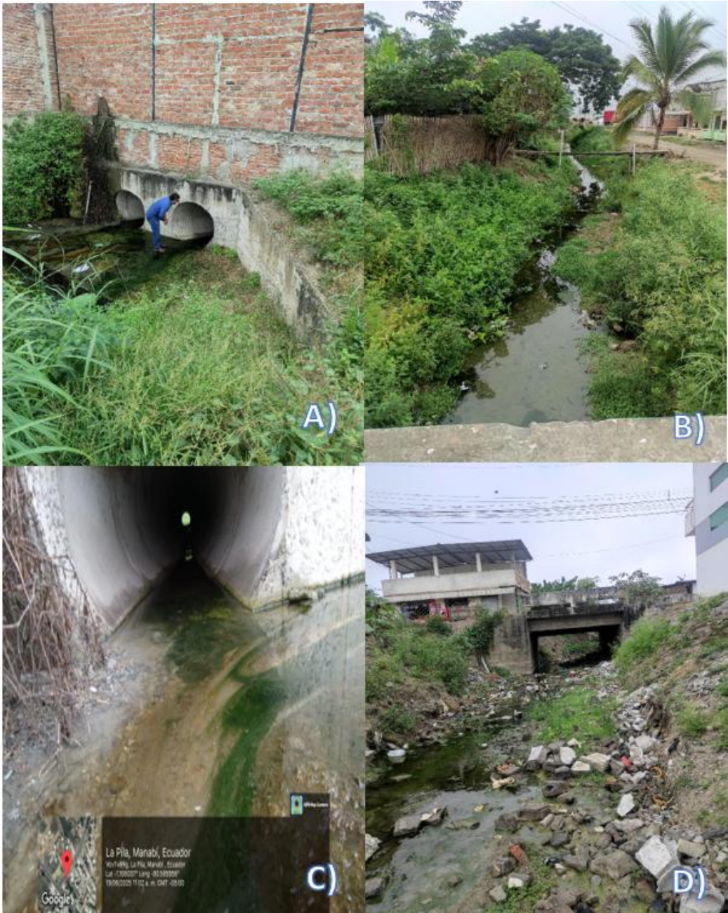
Figura 16. Evaluación visual del sistema de alcantarillado pluvial en el sector La Pila, Manabí
